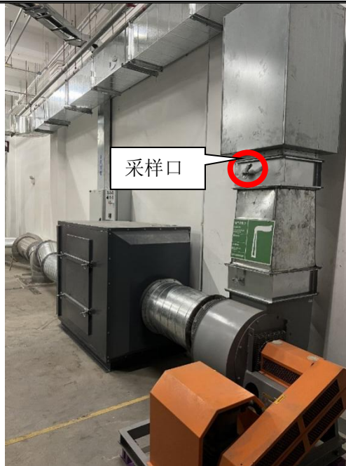
动力总成试验排气筒 DA011 15m
