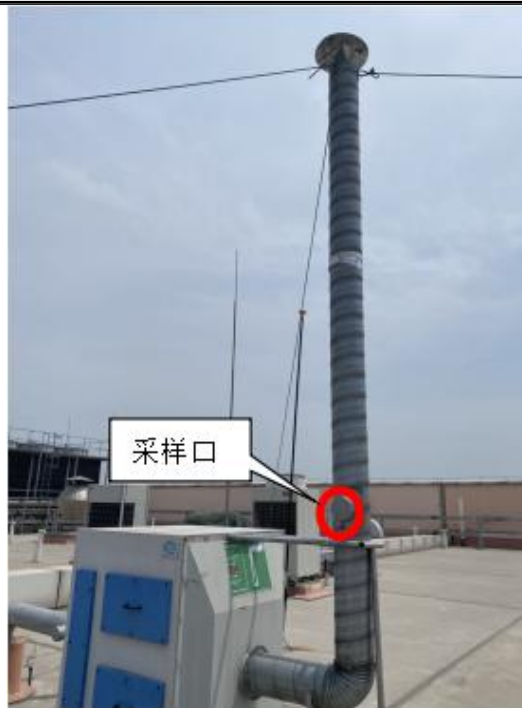
低温整车性能试验废气排气筒 DA005 15m
