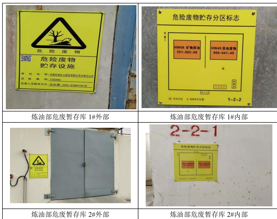
图 2.11-3 危废暂存间规范化设置情况照片
