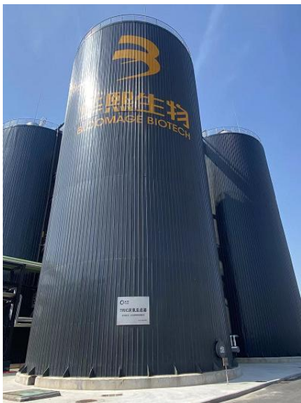
污水站设施—IC 厌氧反应器
