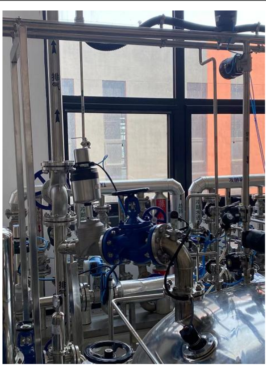
车间内罐体废气收集管道
