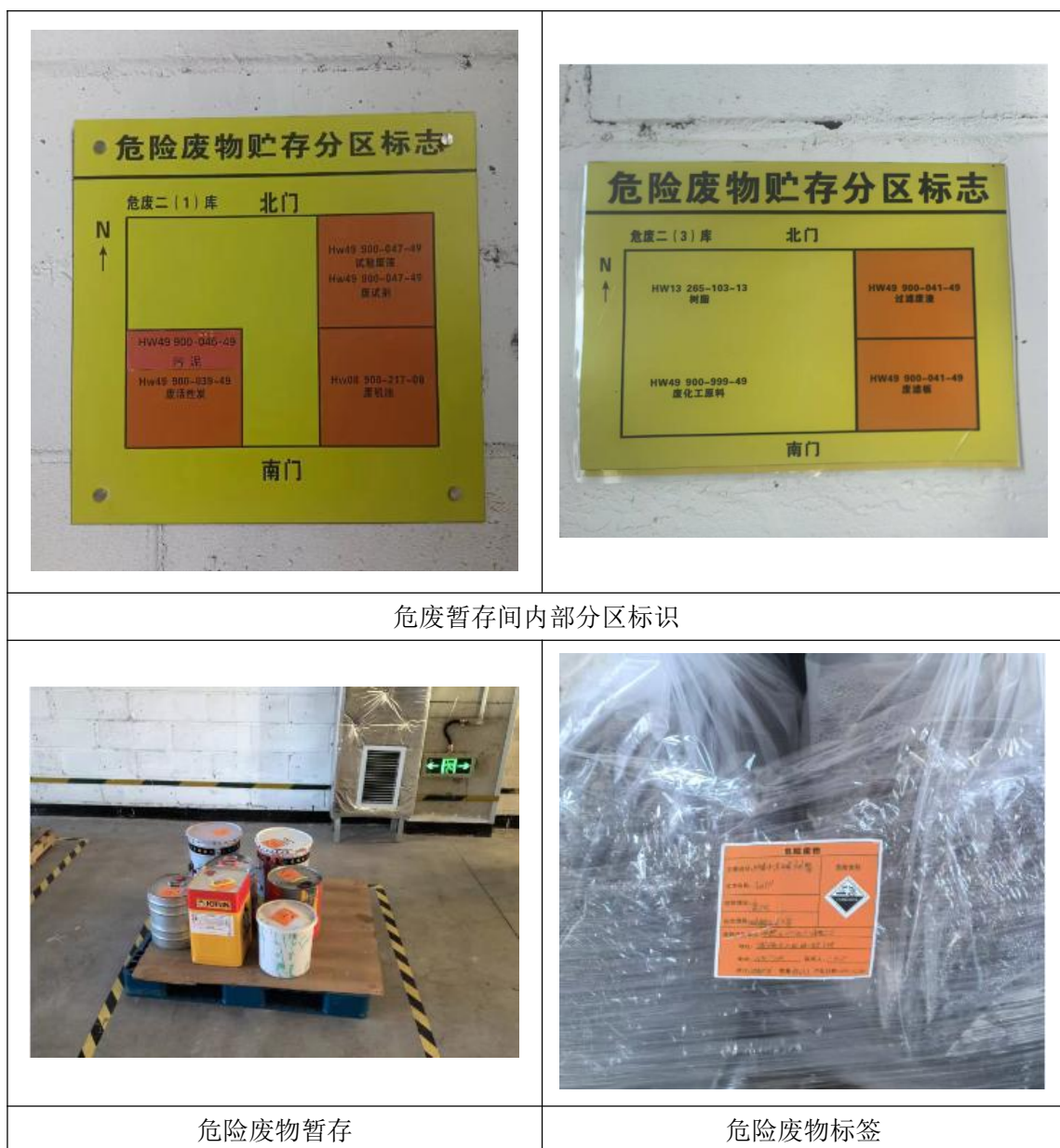
图 4.1-3 本项目固体废物暂存间
