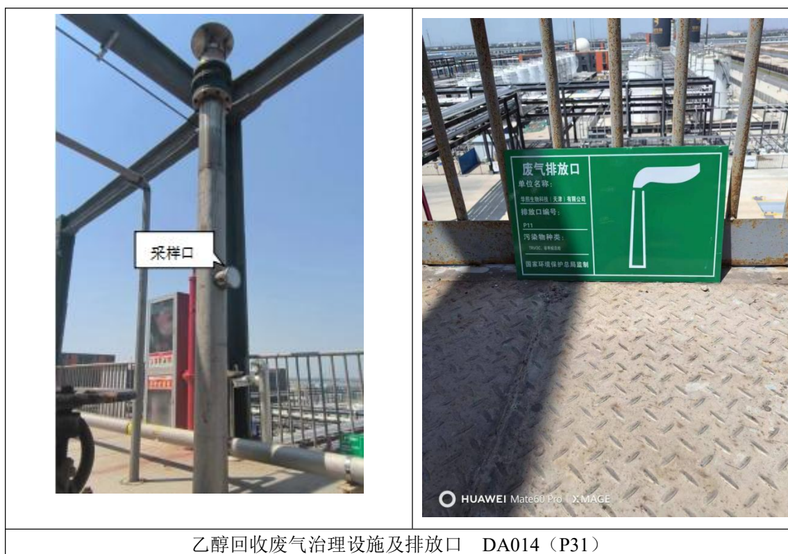
图 4.1-1 废气处理设施及排污口规范化
