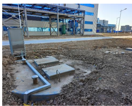
仓库外事故水罐
