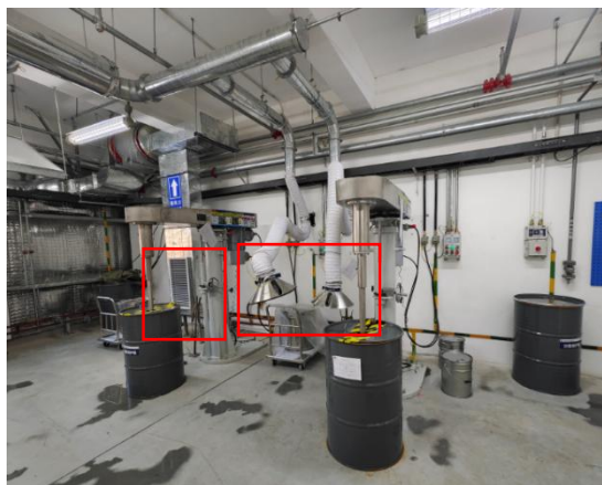
隔间内小批次拉缸废气收集
