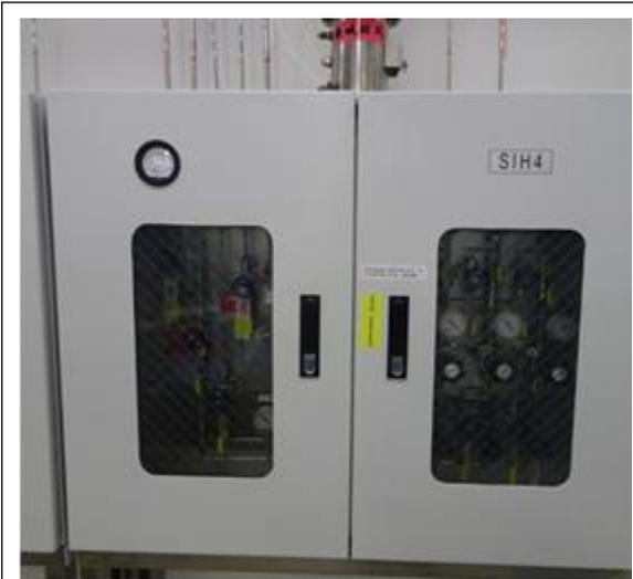
车间特气 VMB (阀门箱), 箱内负压, 负压检测
