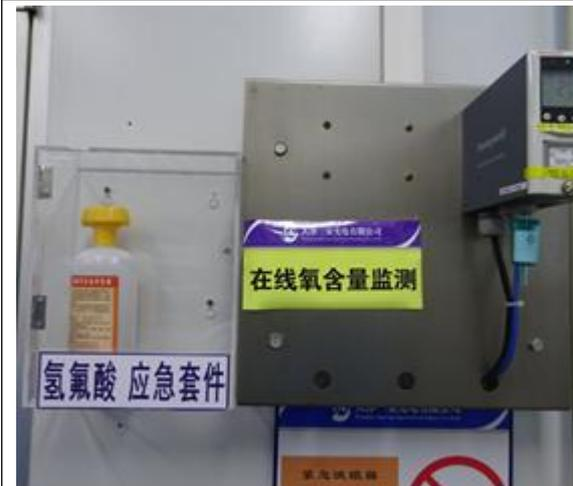
应急冲洗液、惰性气体使用地点氧含量探测
