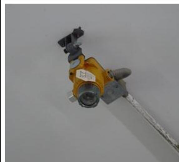
生产车间气瓶间火焰探测器 (报警信号远传至中控室)
