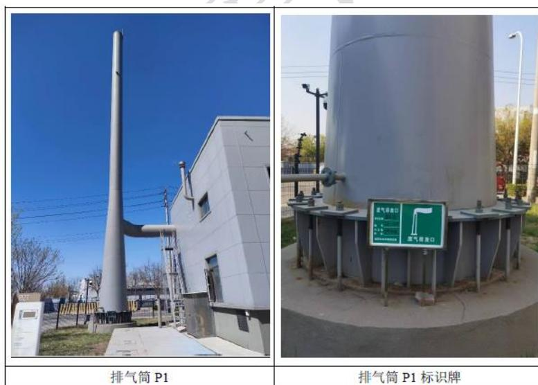
(2)019 污水处理站已建成，处于试运行阶段。根据调查，019 污水处理站涉及的废气排放口为 DA010，已按照津环保监测[2007]57 号《天津市污染源排放口规范化技术要求》等文件进行采样口规范化建设，同时设置了排放口环保标识牌。019 污水处理站设置有 1 个污水总排口位于 019 污水处理站东北侧，设置了排放口环保标识牌，并安装了流量计及 COD、氨氮在线监测设施，监测数据与厂总
