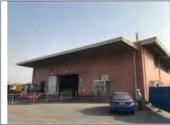
一般固体废物库
