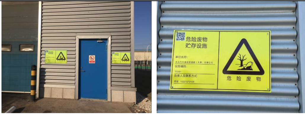
图 2-15 厂区现有危险废物暂存间照片
