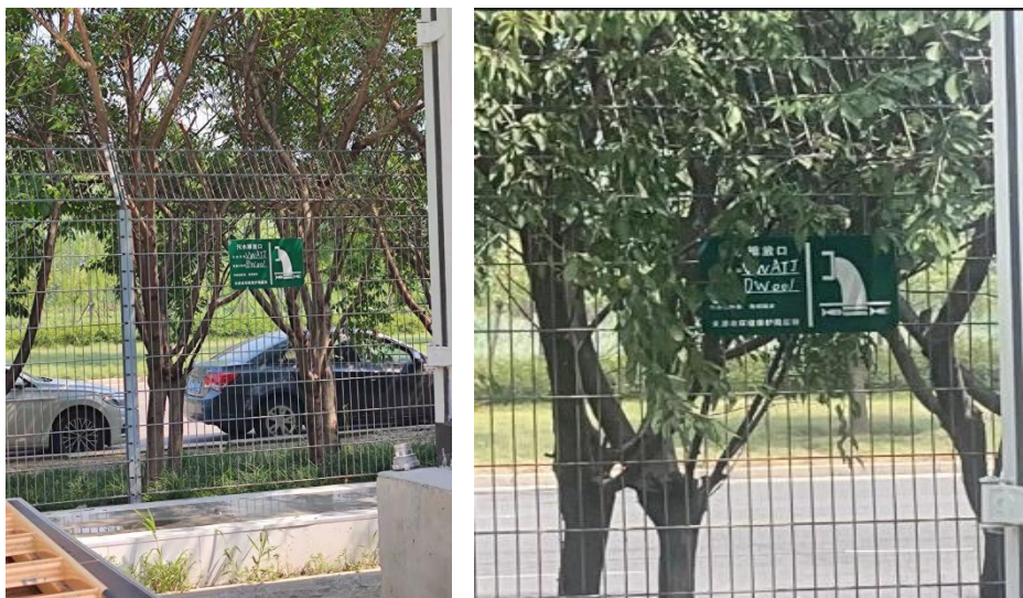
图 2-13 厂区污水总排口及排污口规范化照片
