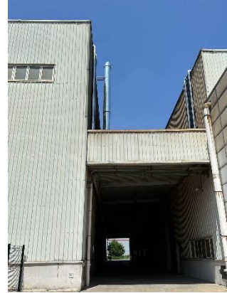
抛丸废气排气筒 DA010
