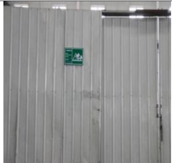
一般固废暂存间
