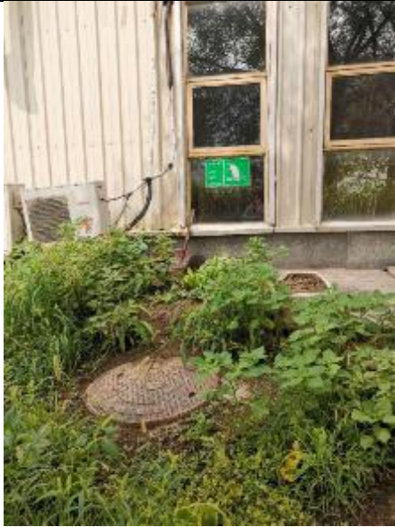
污水总排口规范化
