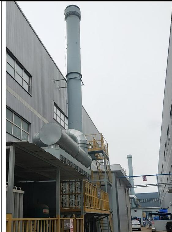
1#废气净化设施—“滤筒除尘器”
