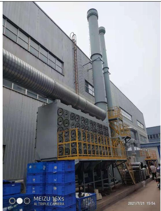
2#废气净化设施—“滤筒除尘器”
