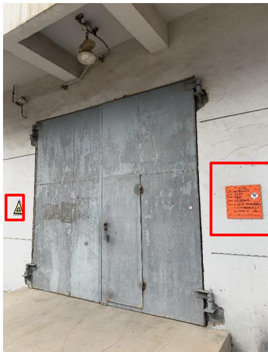
危废暂存间标识牌
