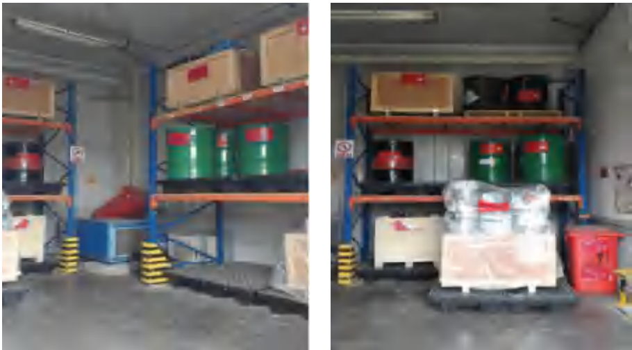
照片 2 危废暂存间现状
