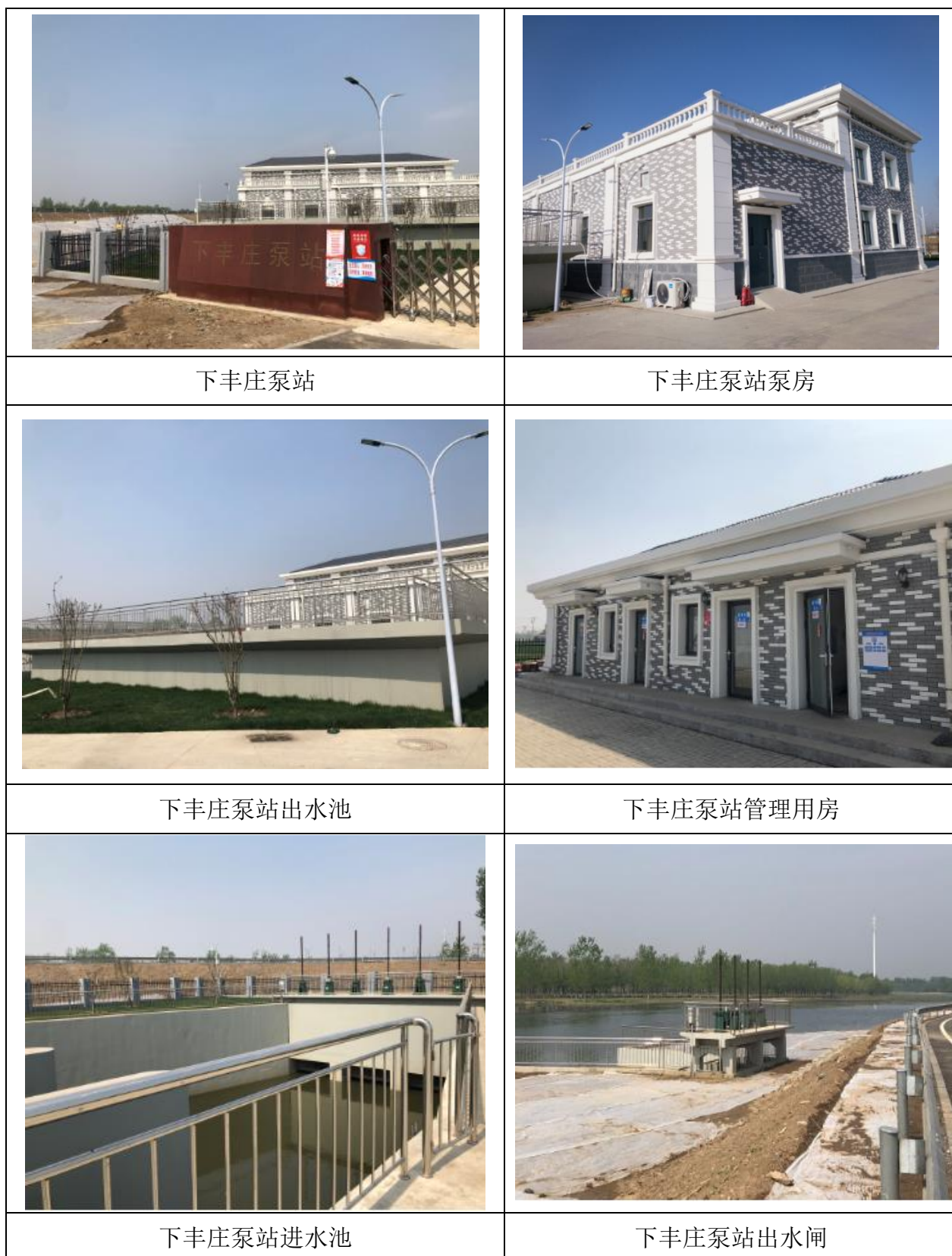
图 2.1-1 下丰庄泵站建成照片
