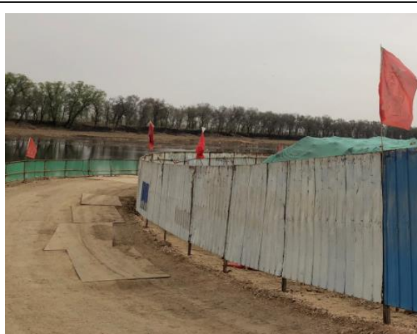
施工区临时道路
