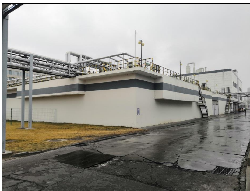
图 13 中环股份园区废水综合处理站
