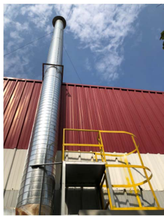
注塑废气排气筒
