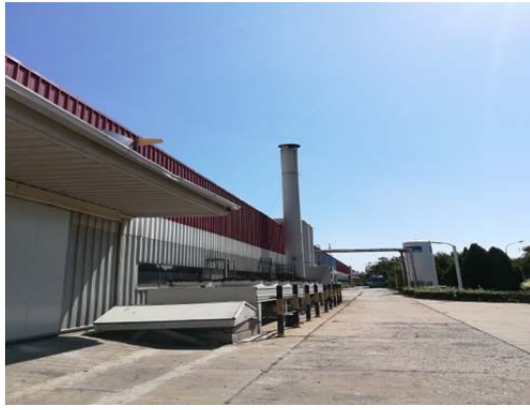
喷漆废气排气筒
